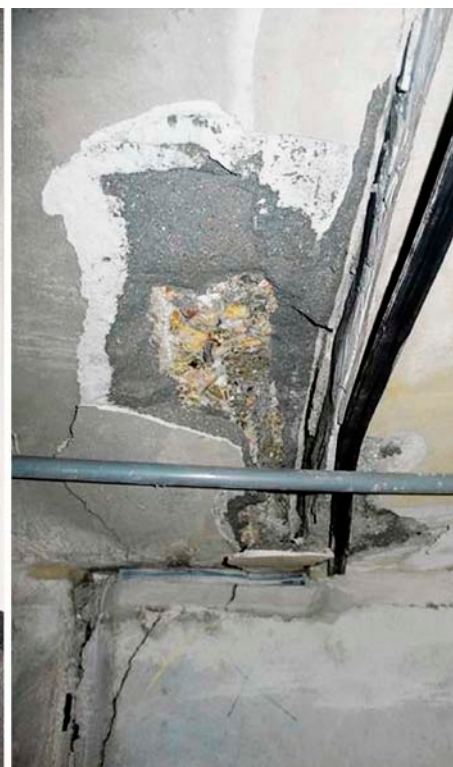
Lekwater in Drechtunnel (links) en afgeboerd beton in het dak van een tunnel.
